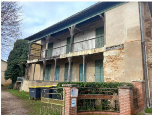
LE PRESBYTERE VU DEPUIS LA RUE GRAND RUE
