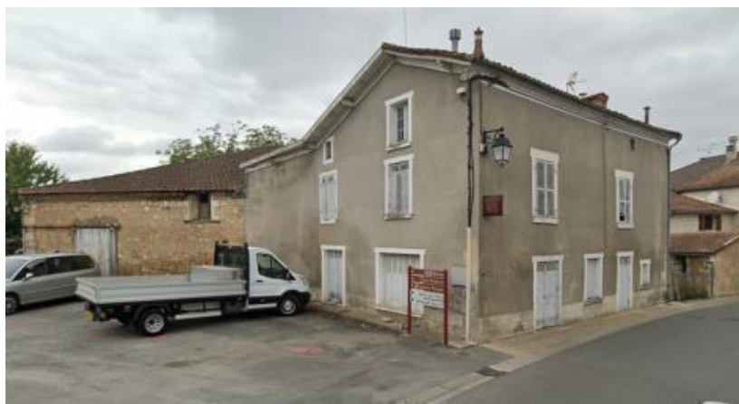
Etat actuel du bâtiment du premier volet du projet.
